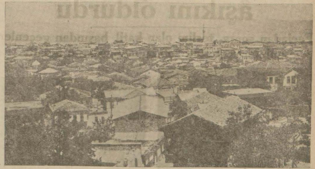
Burdurun umumi görünüşü
